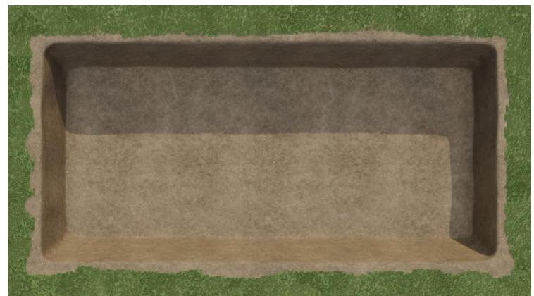
\* Bei Nassbereichen oder Grundwasser sollte ein Drainageband (ca. 0,5 m) um das Becken gelegt werden. Entwässerungsleitungen sind auf ganzer Länge mit einer 20 cm dicken Filterummantelung z.B. aus gewaschenem Grobkies, Hüttensand, Blähton oder Geotextil zu umgeben. Der Abfluss sollte mit dem Inspektionsschacht verbunden werden, aus dem überschüssiges Wasser abgepumpt werden kann.
